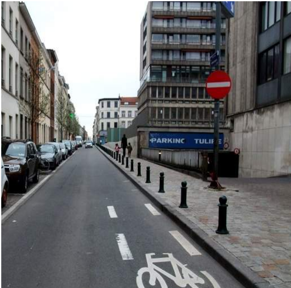
Le SUL de la rue située devant le parking Tulipe est un excellent exemple, dont la largeur est suffisamment large pour permettre le croisement de cyclistes venant à contre-sens.
